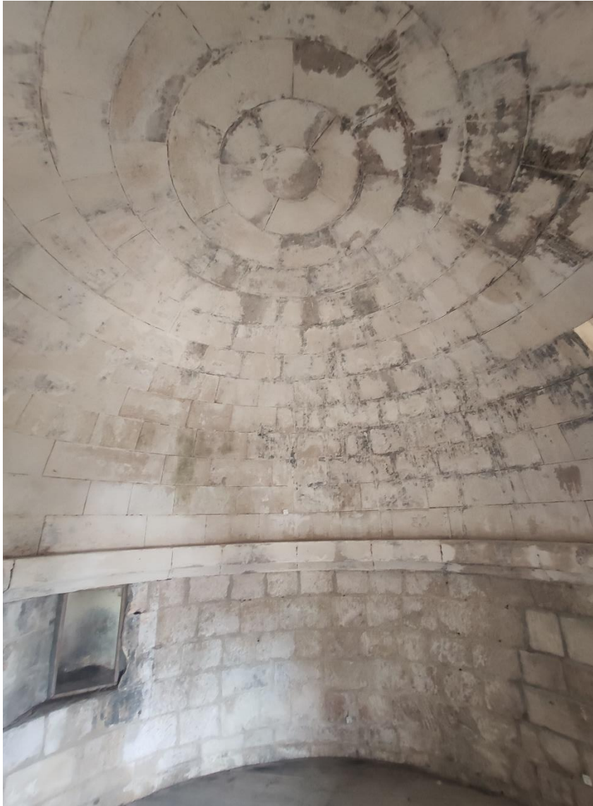
L'intérieur de la tour vue depuis le niveau intermédiaire, sur la coursi
